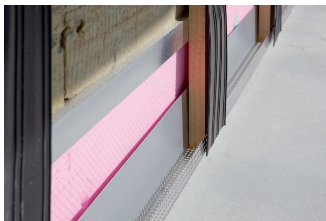
Abb. 1: Sockeldämmung
